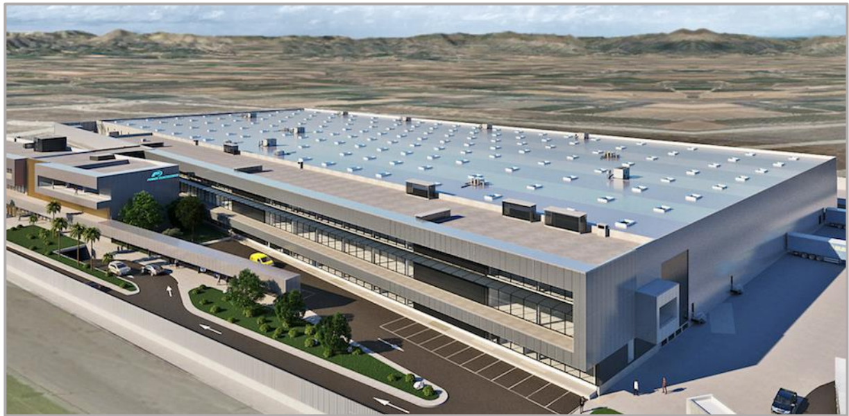
Figura 2.1: Instalaciones de Power Electronics en Llíria.
